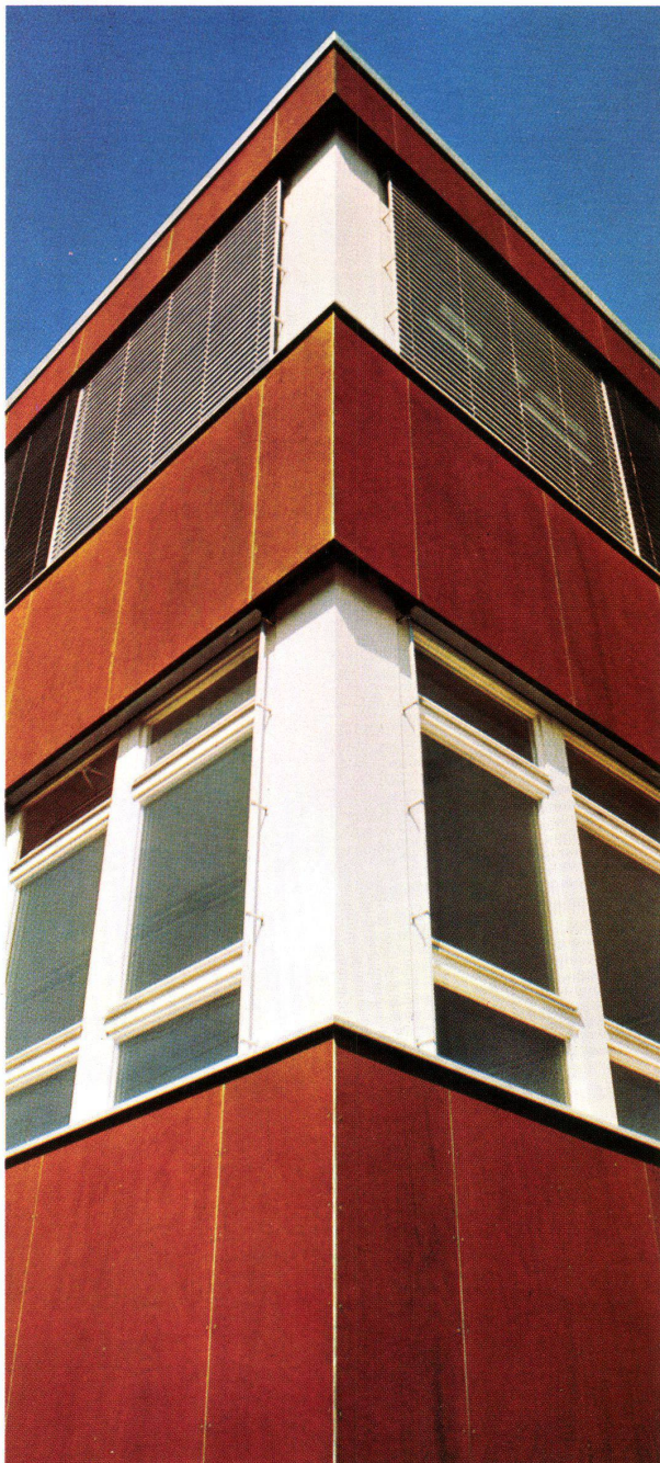
Industriegebäude: Gebr. Gläser AG, Schreinerei, 5513 Dättwil
