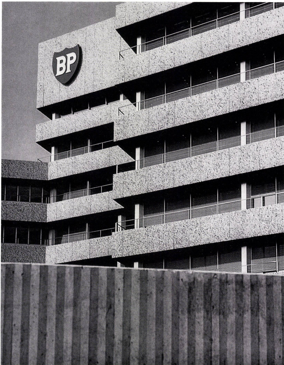
10 Nottreppenhaus in Verbindung mit den umlaufenden Fluchtbalkonen in jedem Geschoß. Escalier de secours. Emergency stairwell.
