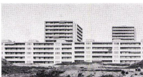
Überbauung Les Bergières in Lausanne. Bauherr: Rentenanstalt Zürich. 250 Wohnungen.
