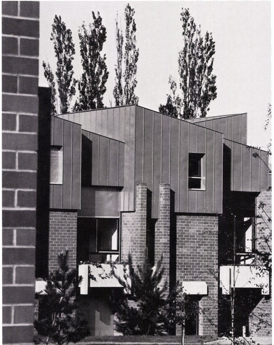
4 Dachdetail mit Kupferverkleidung. Détail de toiture montrant le revêtement en cuivre. Roof detail with copper sheeting.
