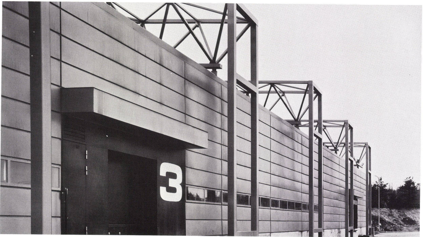
7 Ausschnitt von der Ostfassade der Fabrikationshalle. Détail de la façade est du hall de fabrication. Detail of the east elevation of the factory.
