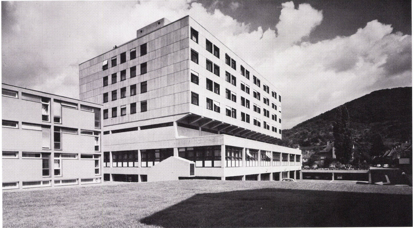
1 Ansicht Eingangsseite. Tragwerk heller Sichtbeton. Fassade Bettenhaus naturgraue Eternitplatten, Fassadenelement Erdgeschoß dunkles Mahagoniholz mit Brüstungen aus Weißeternit.
