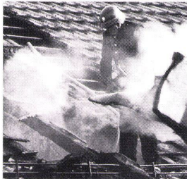
Die Feuerwehr schafft durch Aufreissen des Daches Abzugsmöglichkeiten.
