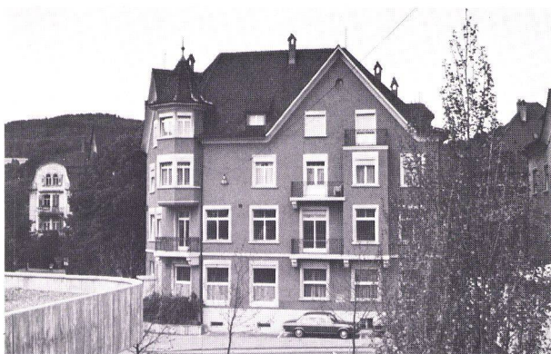
Kt. Aargau: Nachträglicher Einbau von ALUMBRA-Rolläden
