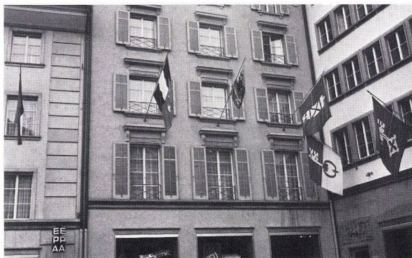
Kt. Luzern: Ersatz von alten JALOUSIELADEN durch neue
