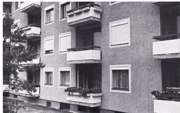
Kt. Zürich: Nachträglicher Einbau von ALUMBRINO-Rolläden
