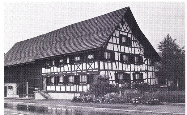
Kt. Zürich: Ersatz von alten JALOUSIELADEN durch neue
