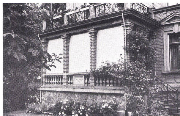
Kt. Bern: Nachträglicher Einbau von ALUMBRA-Rolläden
