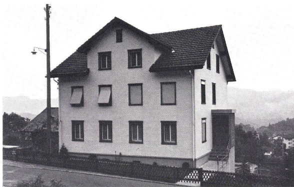
Kt. St. Gallen: Nachträglicher Einbau von ALUMBRA-Rolläden
