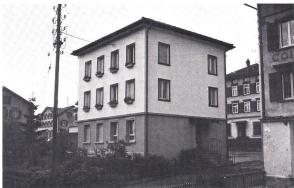
Kt. St. Gallen: Einbau von ALUMBRA-Rolläden
