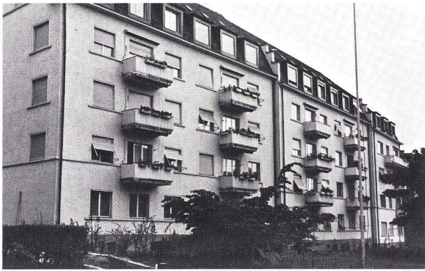
Kt. Zürich: Ersatz von Holzrollladen durch ALUMBRA-Rollladen
