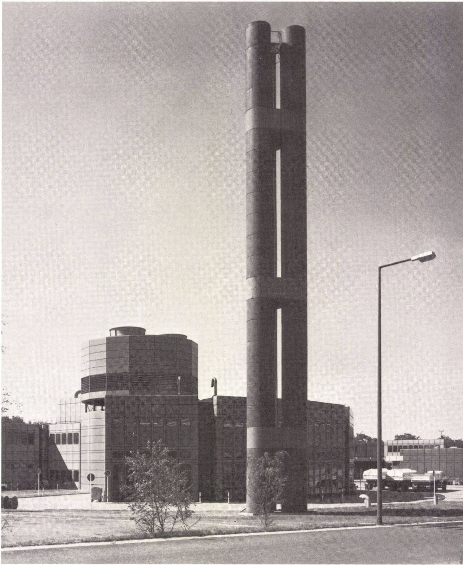
37 Energiezentrale mit Schornsteingruppe. Rückkühlwerk auf dem Dach.
