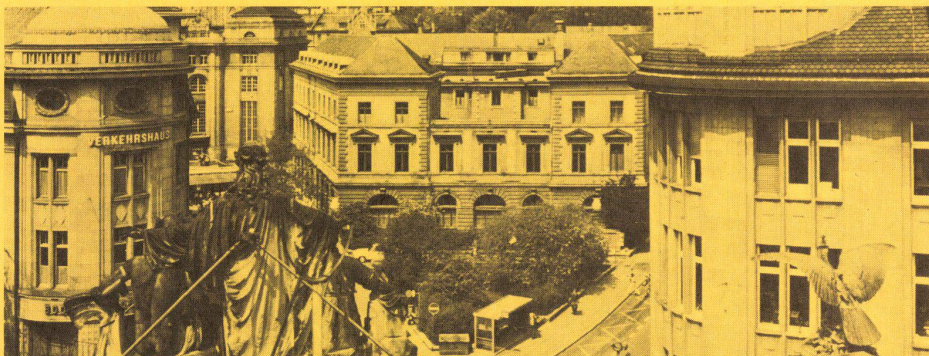
Blick über die Helvetiakreuzung in Richtung Bahnhof und neues Rathaus.
