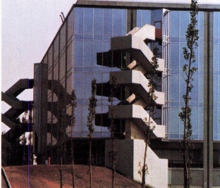
IBM Italia, Milano-Segrate, Italien, 1975 INFRASTOP-Auresin 39/28 Arch. Zanuso, Mailand
