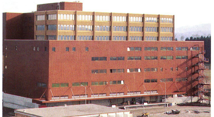
Jowa Grossbäckerei, CH-Volketswil, 1977 INFRASTOP-Silber 36/33 R. Busenhart Architekten AG, Uster
