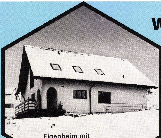
Eigenheim mit Wärmepumpen-Heizung
