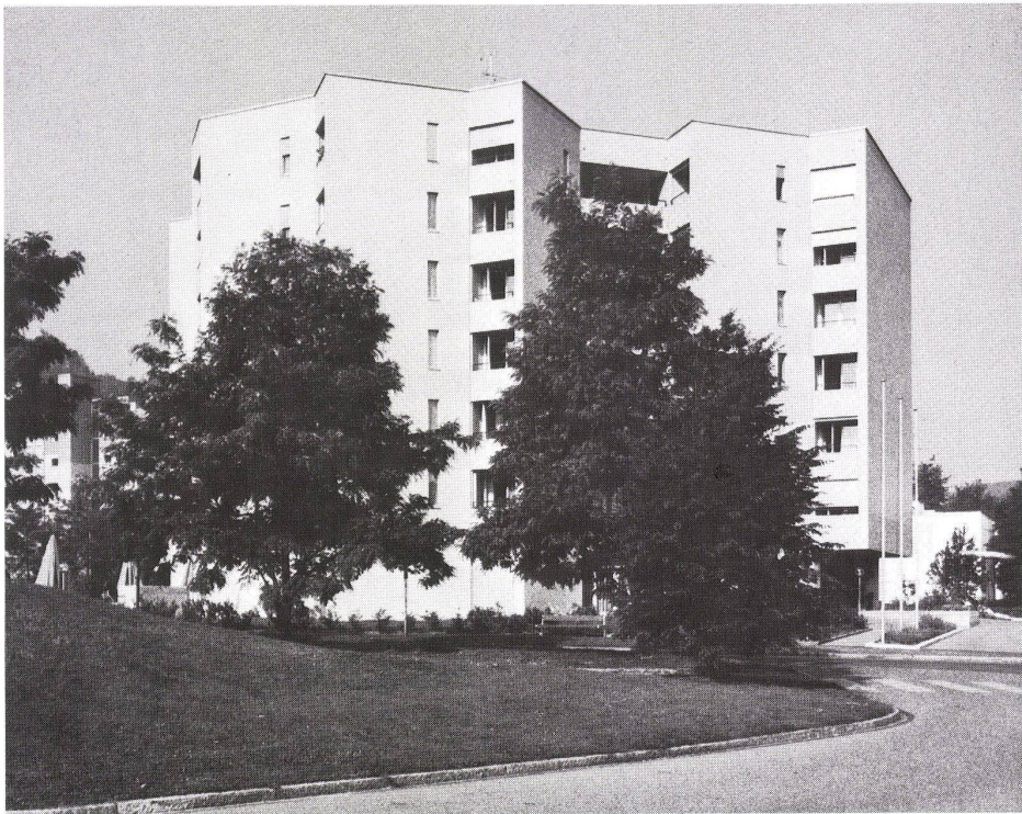
9 Ansicht von Osten, rechts Haupteingang. Vue de l'est, à droite l'entrée principale. Elevation view from east, right, main entrance.
