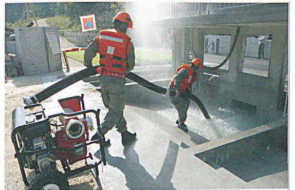
Demonstration der Zivilschutzpioniere: Einsatz der Schmutzwasserpumpe an der Mehrzweckstation.
