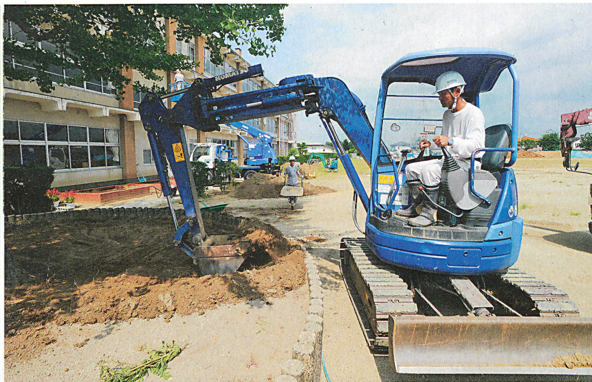
Im August 2011 entfernt ein Stadtangestellter von Fukushima im Hof einer Grundschule radioaktiv belastete Erde aus einem Blumenbeet.
