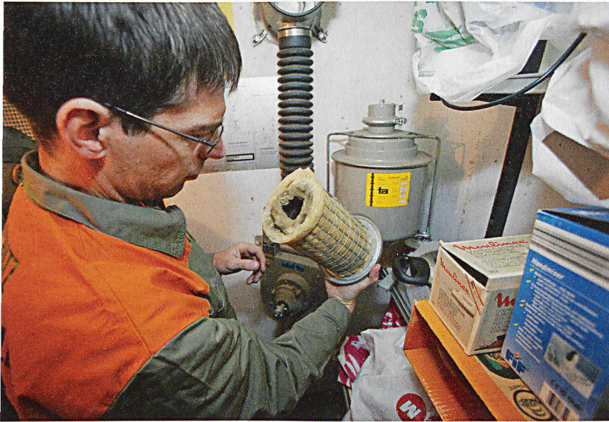
Matthias Lüscher kontrolliert einen Luftfilter und setzt danach die Lüftungsanlage in Gang.
