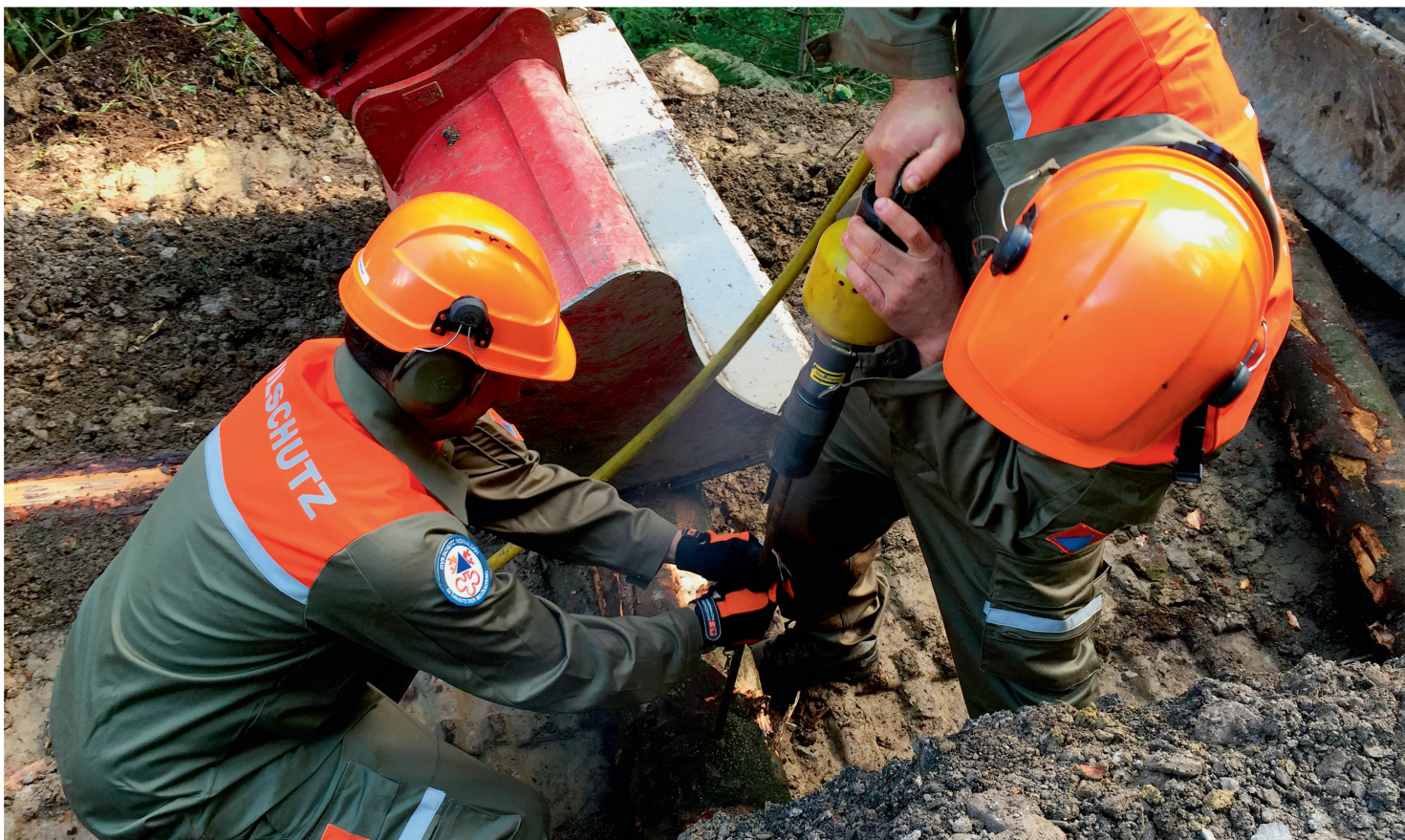
Instandstellungsarbeiten sollen neu als Ausbildung gelten und als Wiederholungskurse geleistet werden. Im Bild: Pioniere der Zivilschutzorganisation Nidwalden verschrauben Holzstämmen mit Armierungsseisen.
