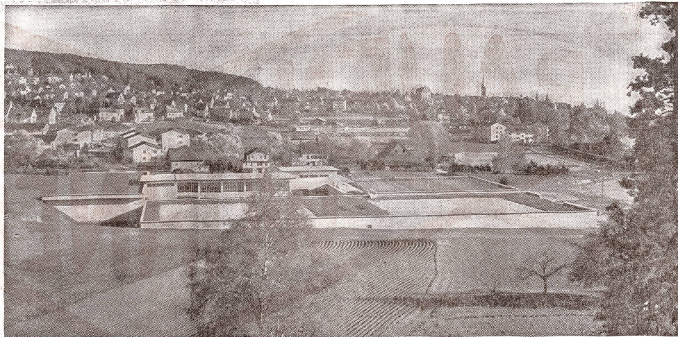
Zürichs zweites Seewasserwerk. Gesamtsituation der Filteranlage Lengg.
