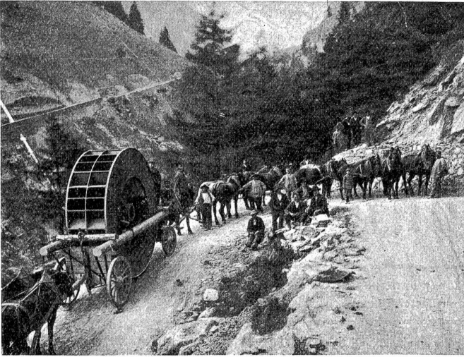
Vom Bau der Lötschbergbahn. Rad eines der großen Ventilatoren zur Beforgung der Ventilation des großen Souterrains auf der Südseite des Tunnels bei Goppenstein. Schwieriger Transport auf der Straße von Gampel nach Goppenstein.
