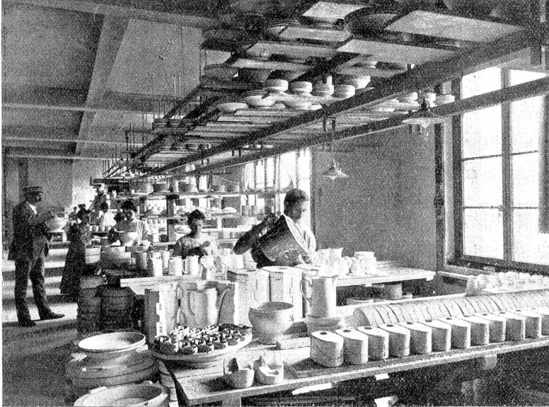
Porzellanfabrik Langenthal: Giesserei.
