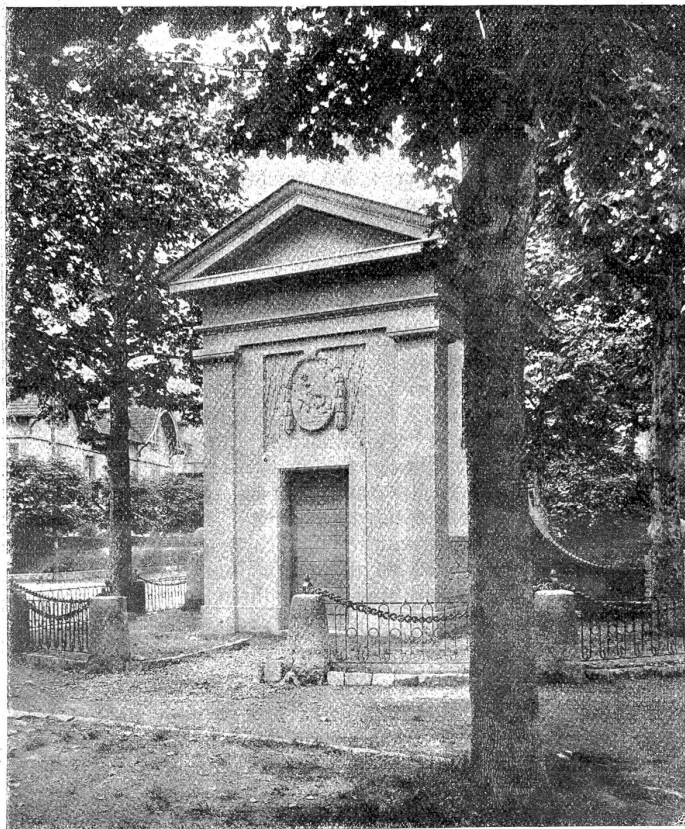
Transformatorenhäuschen an der Zieglerstrasse.
