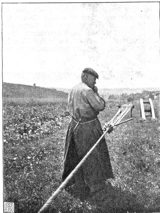
Leitholzführer beim Versellen eines Drahtseils durch Handfabrikation.
