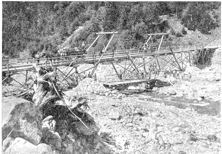
Die neue Hoflandernbrücke über die Sense mit Notübergang und Umgelände.
