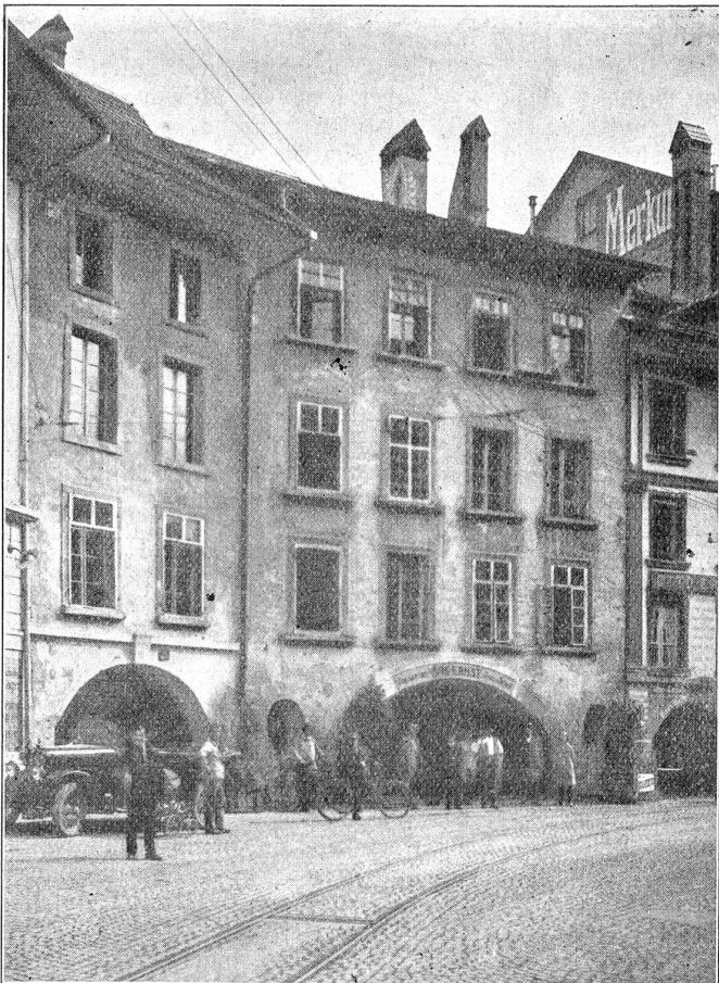
Der Scharnachtalhof in Thun. — Vor dem Abbruch.
