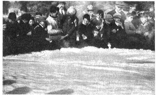
Brennender Oeltank wenige Sekunden später mit einer 20 cm hohen Schaumhöhe.
