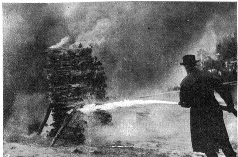
Löschen eines brennenden Holzstoßes. Der Schaum bricht wie ein Wasserstrahl aus dem Wendrohr hervor.
