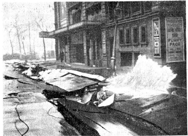
Die Gaskatastrophe in London. Ansicht eines Teils der Unglücksstätte mit aufgerissenen Pflaster und brennendem Gas.
