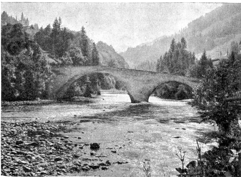
Abb. 4. Alte Steinbrücke über die Saane, Kanton Sriburg. Verschieden große Oeffnungen, den Gründungsverhältnissen angepaßt, der Scheitel über dem höhern Bogen.
