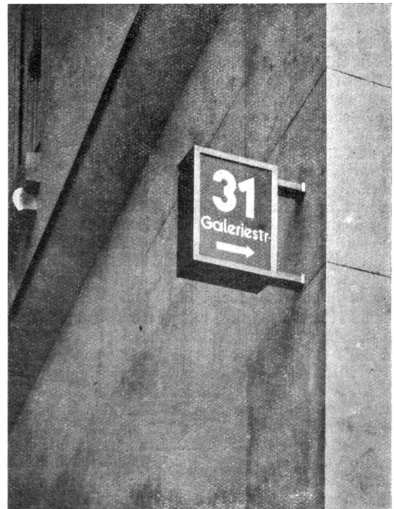
Hausnummer am Postamt Galeriestrasse in München. Duranametall und transparentes Ueberfangglas mit weiss ausgeblasener Schrift.
