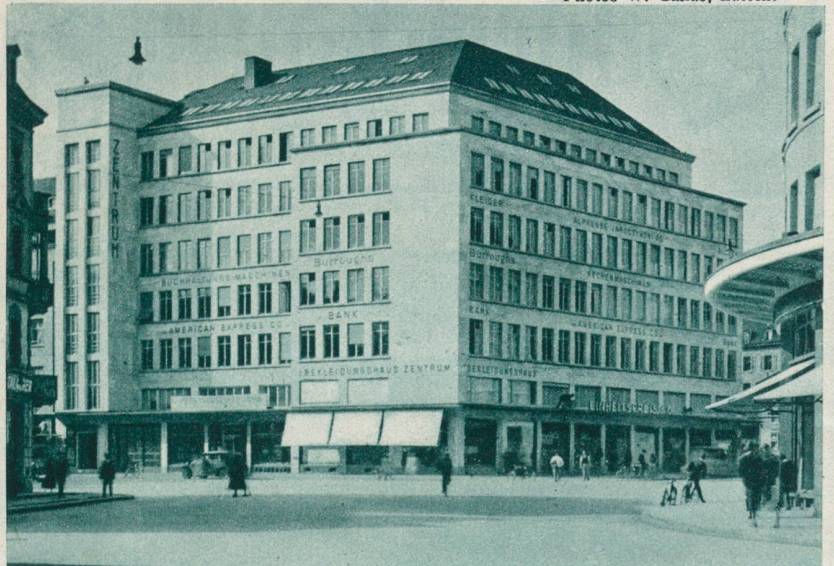
Das neue Geschäftshaus zum «Zentrum» an der Sihlstrasse.
