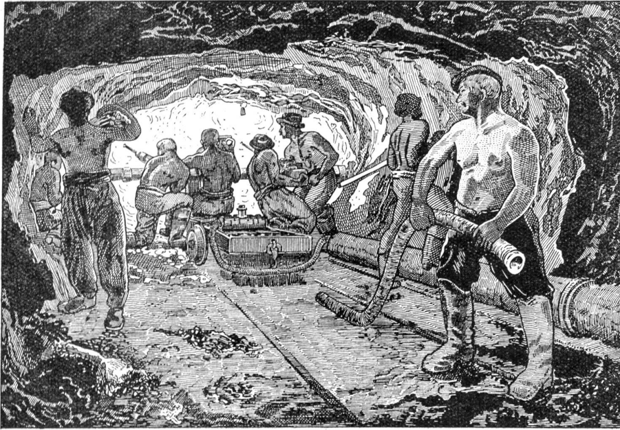
Vom Lötschbergdurchstich. — Die Arbeit im Stollen.
