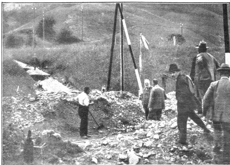
Die verschüttete Burgdorf-Thun-Bahn am Ausgang des Hosbachgrabens.
