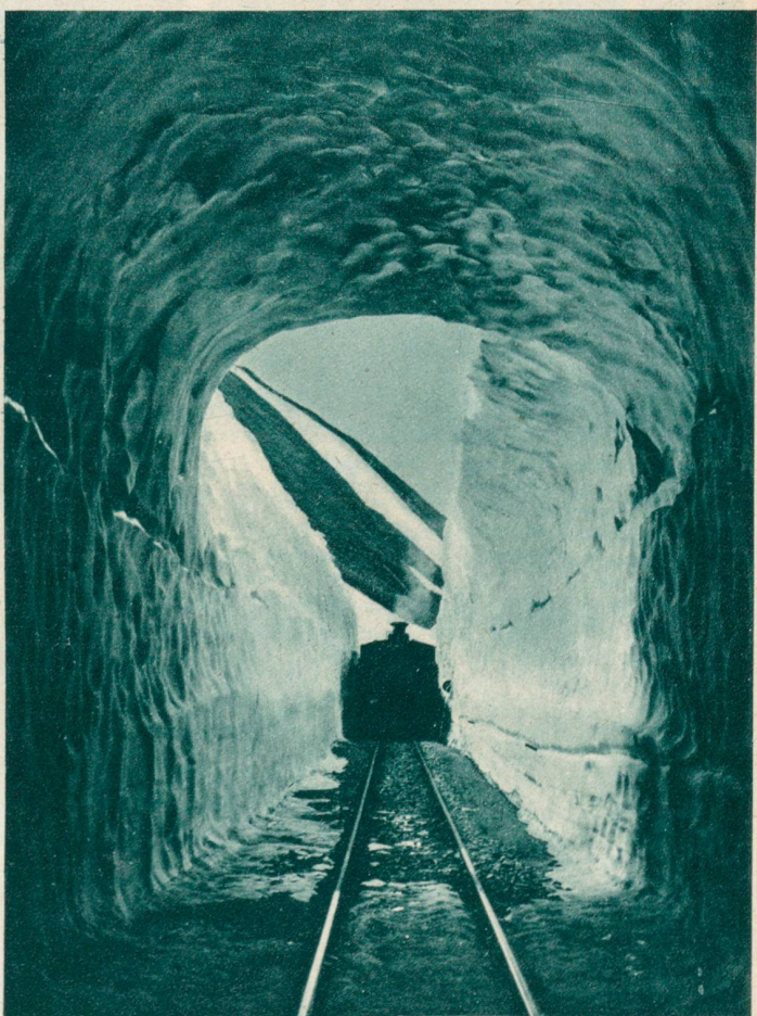
Die Freilegung des Geleises der Furka-Oberalp-Bahn. Die Schneehöhe, welche ausgeschaufelt werden mußte, betrug 12 bis 14 Meter. Zirka 200 Mann arbeiteten 3 Wochen, bis der „Glacier-Expres-Zug“ durchgehen konnte, den unser Bild zeigt. Phot. Schneiter, Thun.
