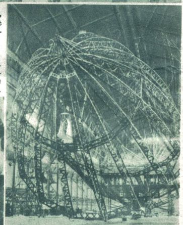
Ein Luftschiff wird verschrotet! Während Amerika sein zweites Riesenluftschiff, System Zeppelin, baut, wird das englische Luftschiff „R 100“ in der Halle zu Cardington abgebrochen. Das Schwesterschiff „R 101“ ist vor zwei Jahren in Frankreich auf der Indienfahrt herabgestürzt und verbrannt. Photo Sennecke, Berlin.
