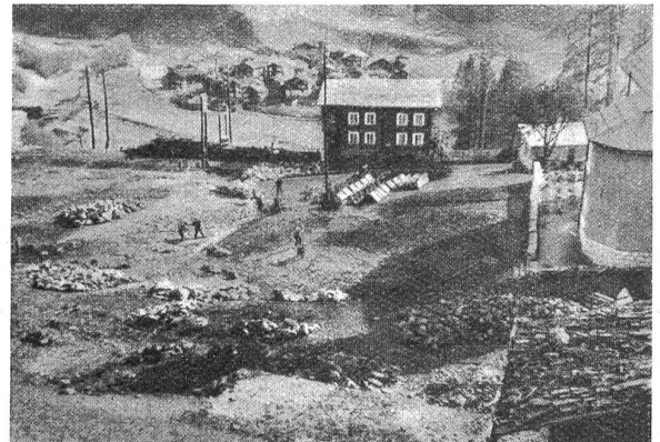
Der aufgeräumte Brandplatz.
