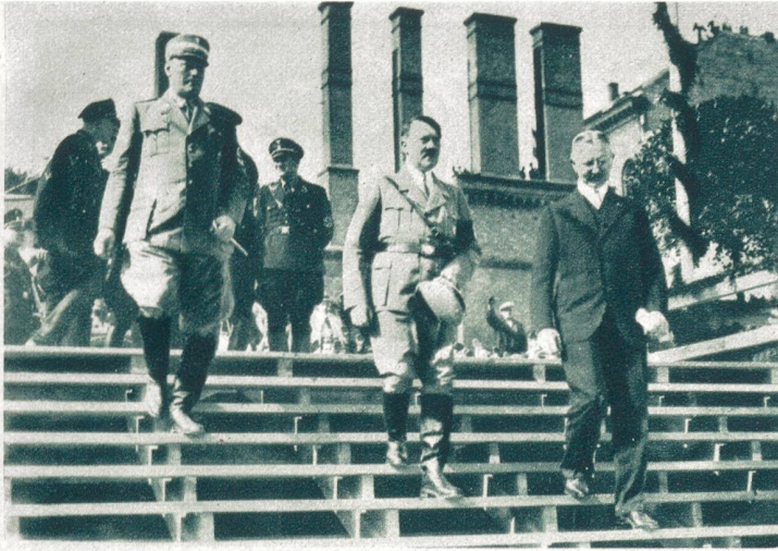
Grundsteinlegung zum Erweiterungsbau der Deutschen Reichsbank in Anwesenheit der Regierung. Unser Bild zeigt den deutschen Reichskanzler mit dem Reichsbankpräsidenten Dr. Schacht auf dem Weg zur Grundsteinlegung.
