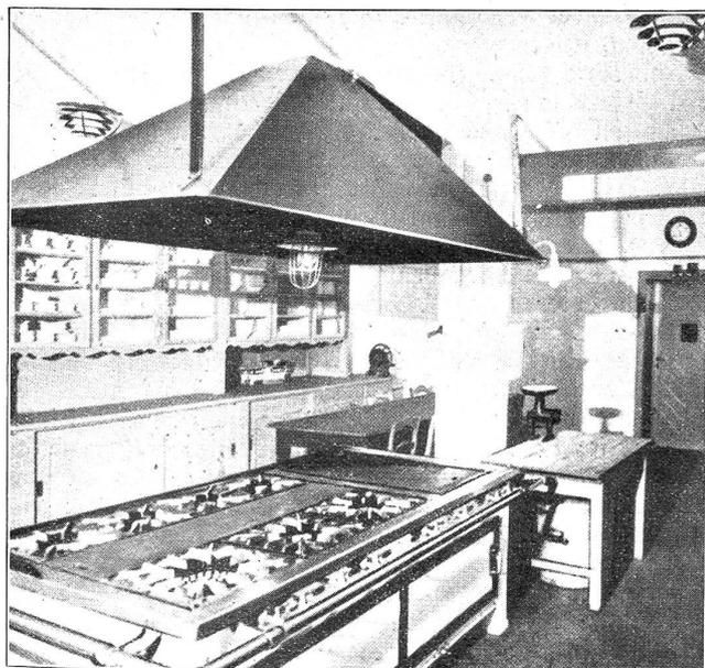
Künstliches Klima in der Küche! Die warme Luft wird durch den über dem Herd liegenden Schornstein abgesaugt; die Zuführung der künstlich vorbehandelten Luft erfolgt durch die an der Decke sichtbaren Apparate.
