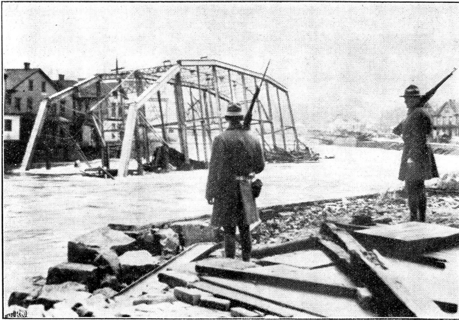
Eine Brücke von der Flut weggeschwemmt.
