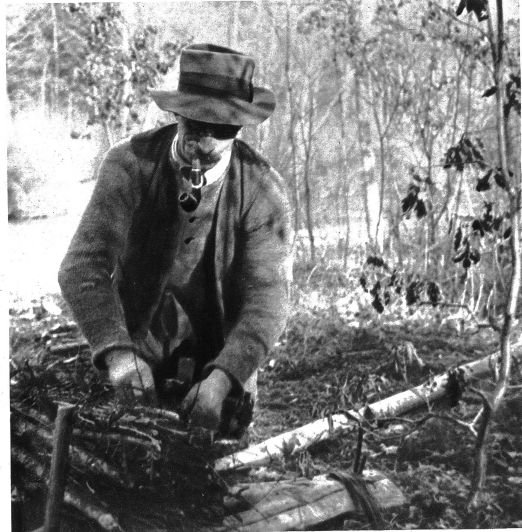
Binden der Weiden für die Verbauung
