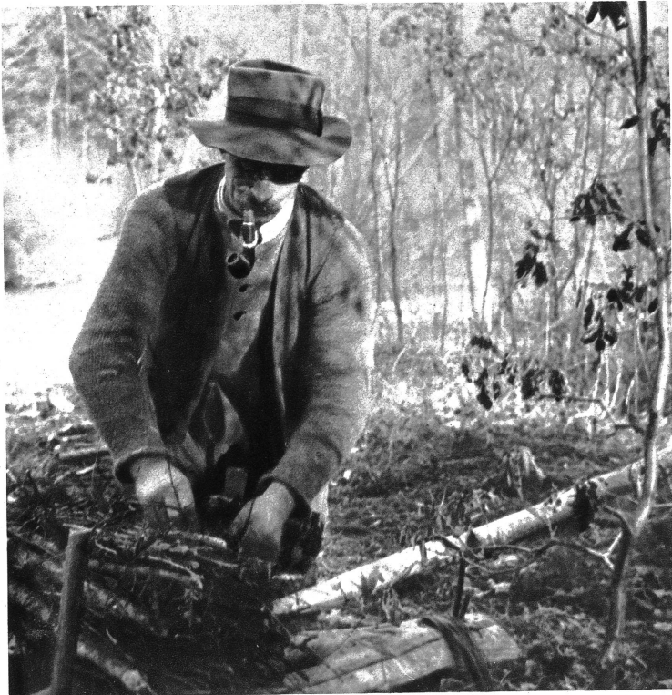
Binden der Wedeln für die Verbauung
