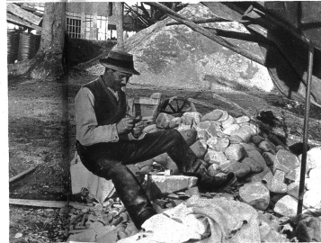
Steine für die Böschung werden hergerichtet
