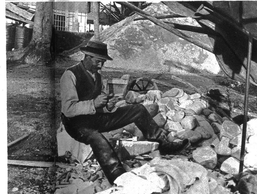
Steine für die Böschung werden hergerichtet
