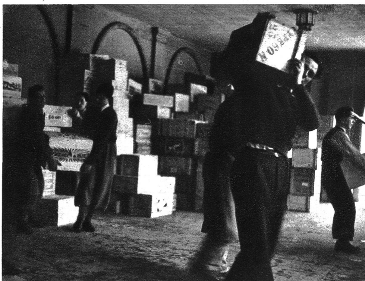
Die Verladung im Berner Schulhaus
