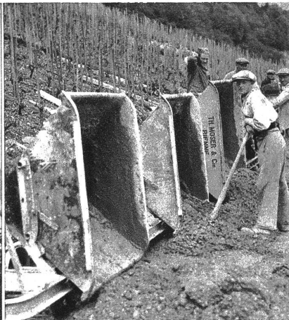
Bau der Rebstrasse
