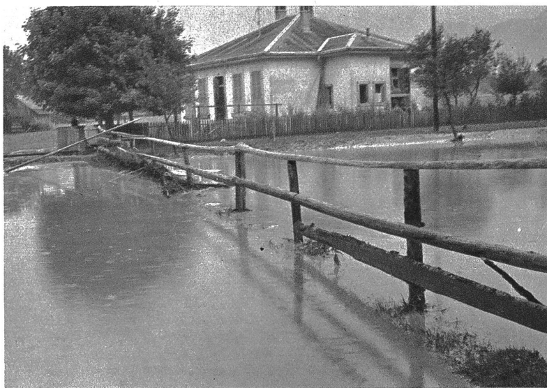
Die überschwemmte Staatsstrasse in Wattenwil
