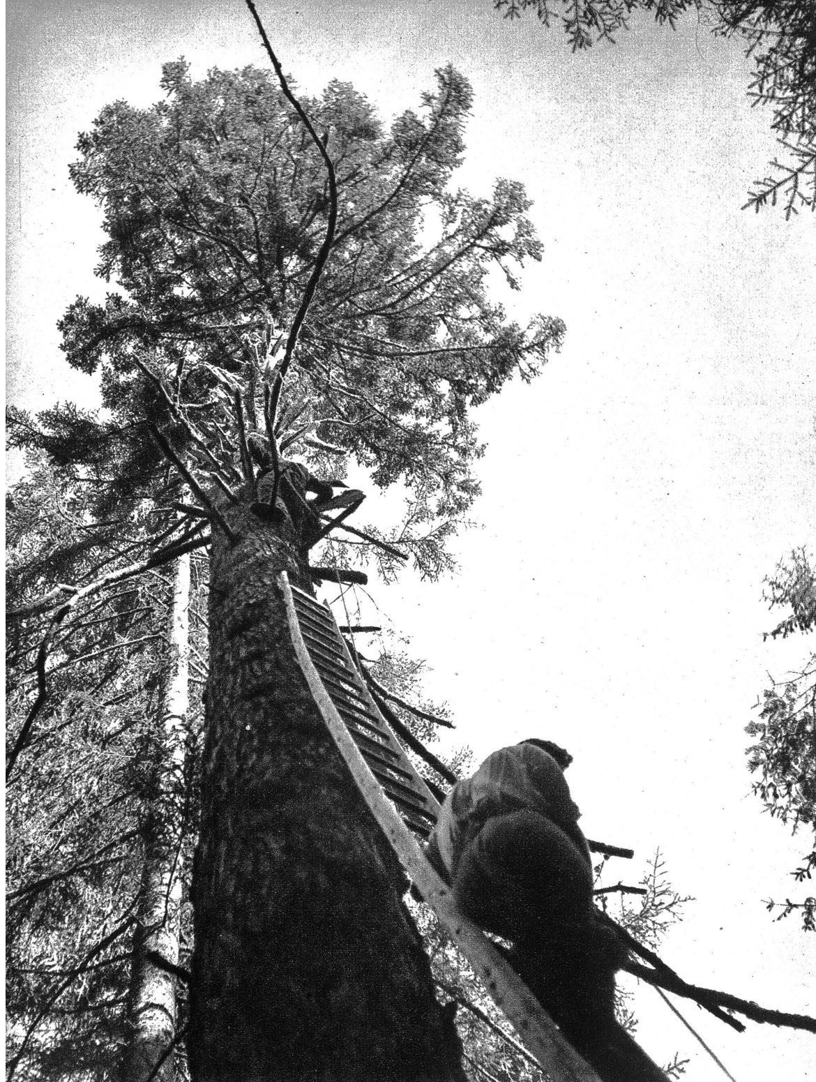
Um zu verhindern, dass die zu fallenden Tannen tief in den schwer zugänglichen Krachert hinunterfallen, steigt man in die oberste Krone hinauf, befestigt hier eine lange Kette und zieht daran die Tanne dorthin wo sie am günstigsten zu liegen kommt.
