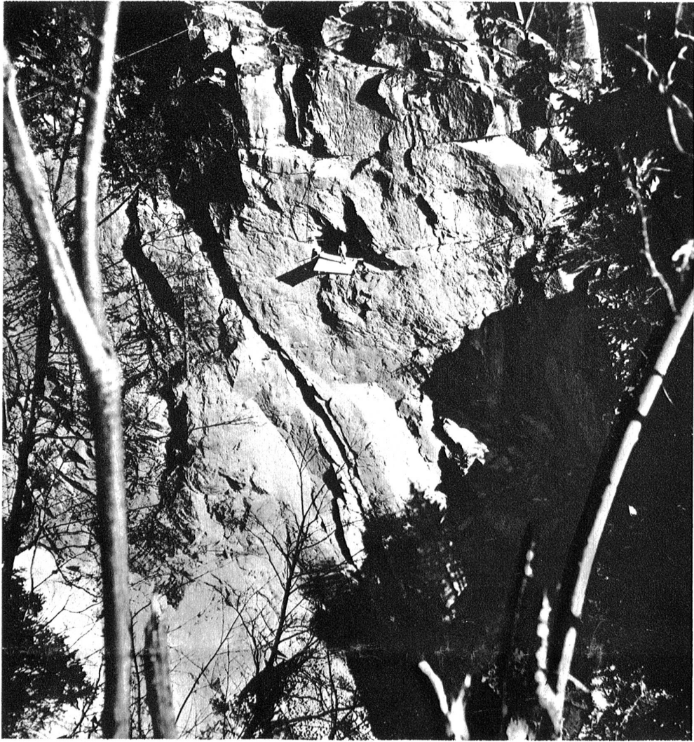
Die Meenschlucht mit dem Stollenausgang für die Erstellung der Brücke.
