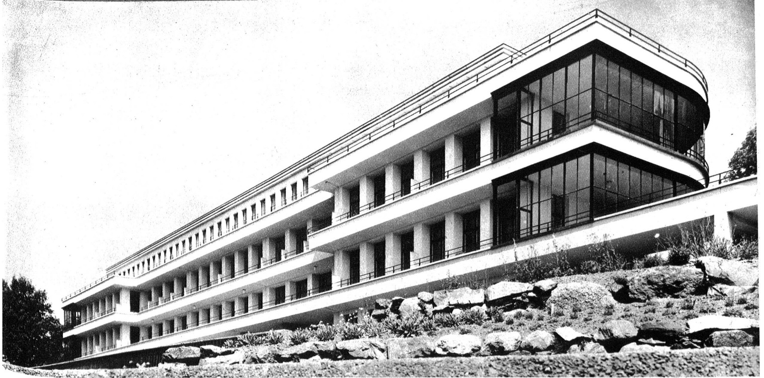
Drei Kunstbauten als Beispiel der Verwendung von Därliger-Zement: Das Lory-Spital in Bern. (Phot. Henn)
