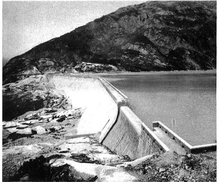
Das gewaltige Werk der Gelmersee-Staumauer für das Grimselwerk.
