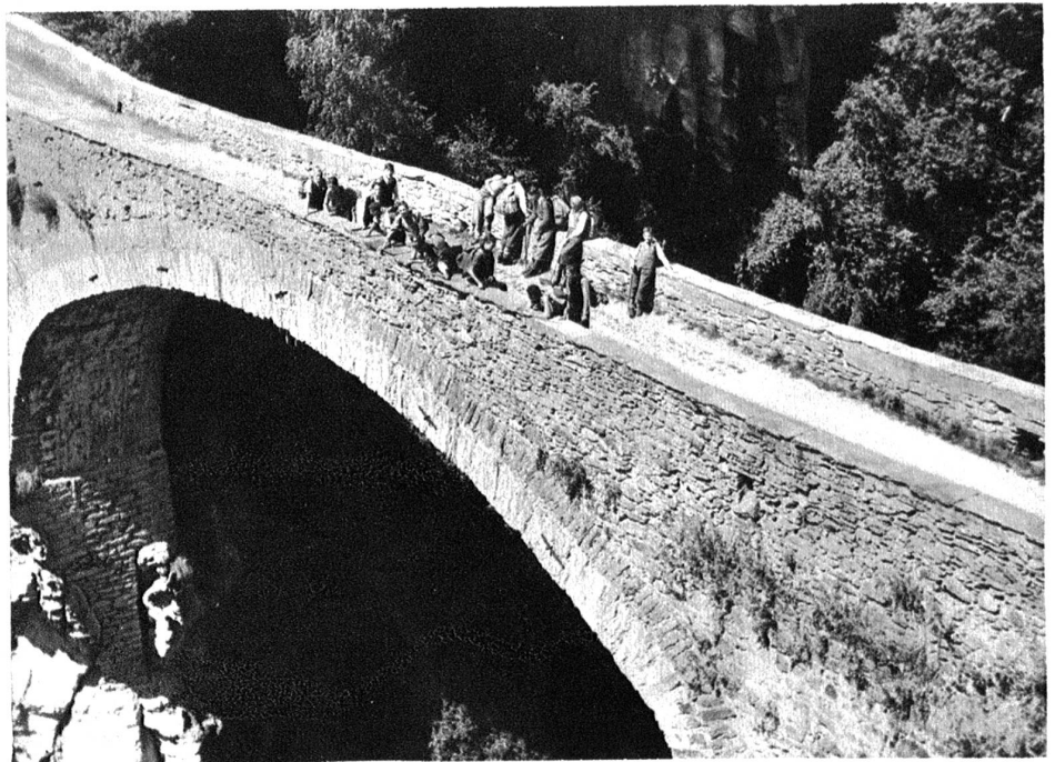
Rast auf der alten Kienbrücke bei Stalden.
