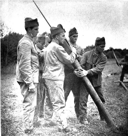
Eine Gruppe rammt Pfähle für eine Landverankerung für die sieben fertig erstellte Brücke.
