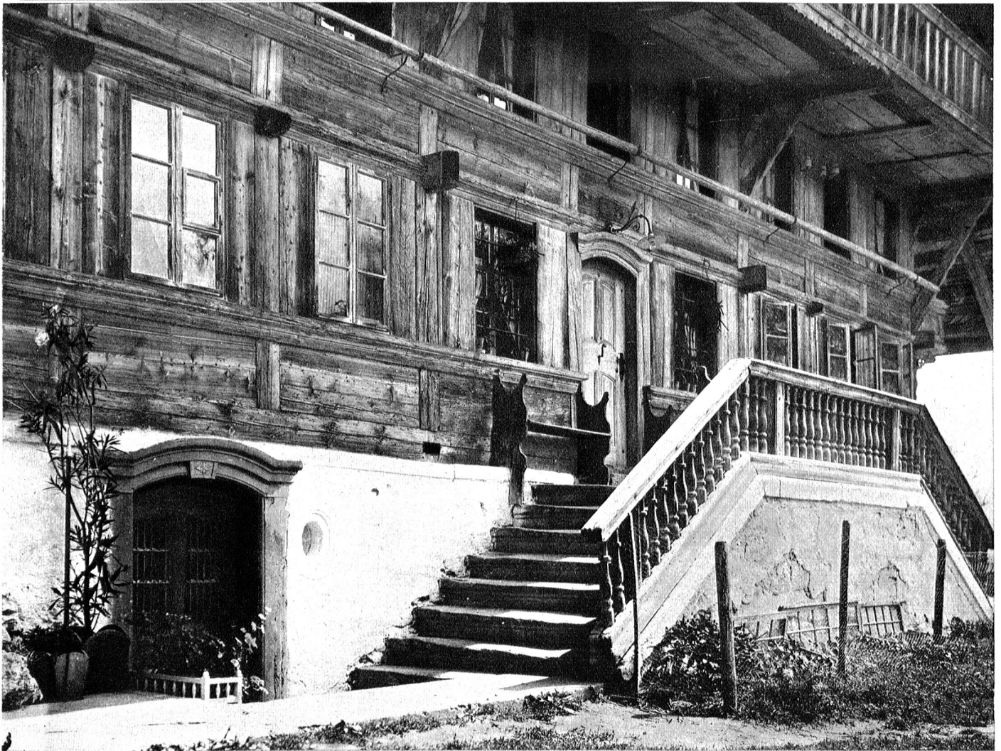
Haus Hertig, Unterfrittenbach 1827.
