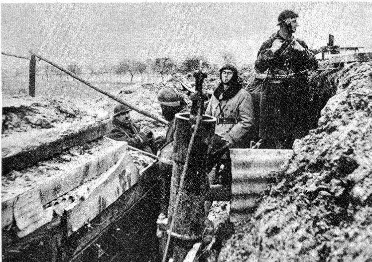
Französischer Beobachtungsstand auf vorgeschobenem Posten. Im Vordergrund erkennt man eine Wasserpumpe zum Entfernen des Graben- oder Grundwassers.
