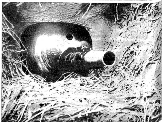
Das Auge des Bunkers. Maschinengewehr in einer getarnten Panzerkuppel. (Photo Atlantic)
